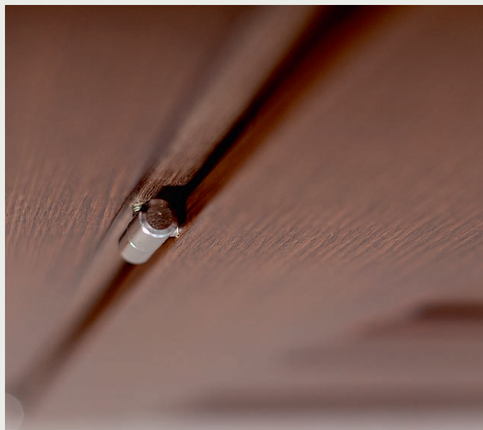
Три ввертные петли установлены.
